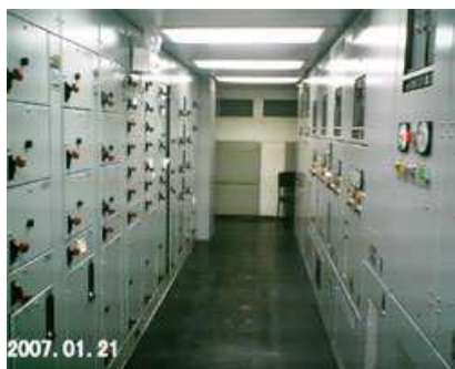
شکل 28 :SCR Unit
